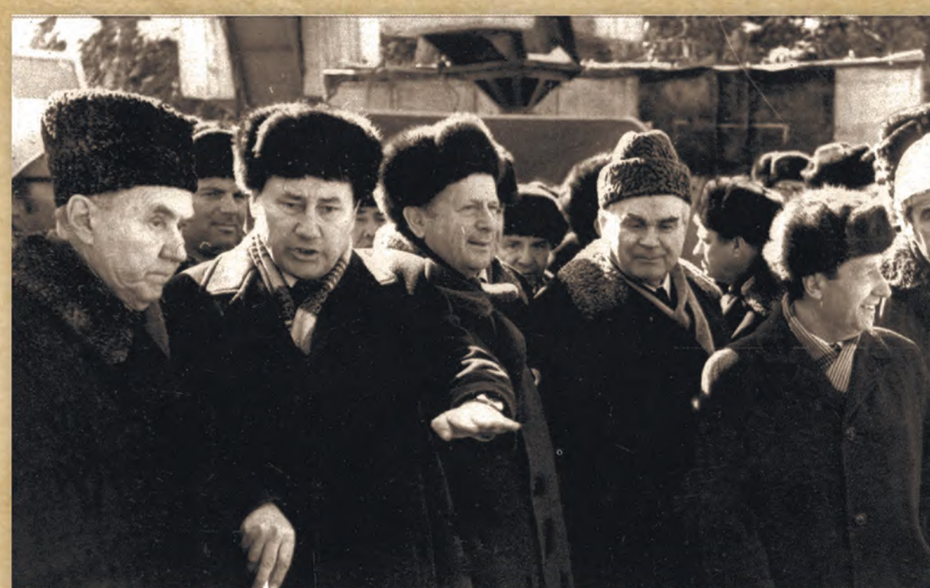
На стройке Саяно-Шушенской ГЭС, 1978 г.
